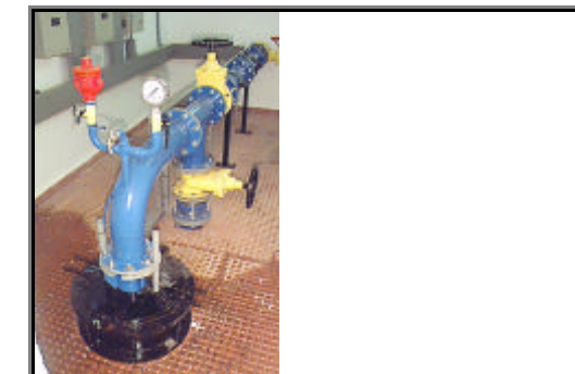
Foto 2 Interior de la arqueta y detalle del sondeo
